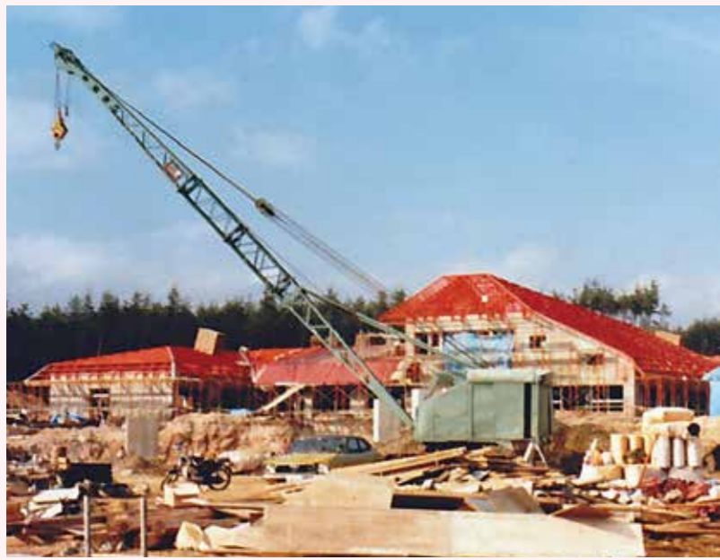
昭和54年 建設中の中山の園
